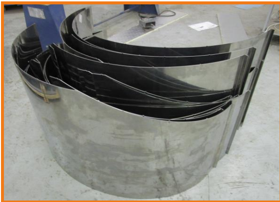
Раскройка металла и изготовление теплообменника
