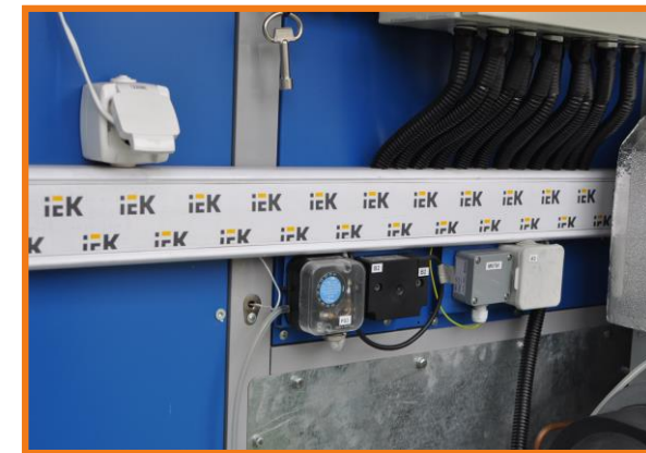
Разводка электрики шкафов и датчиков
