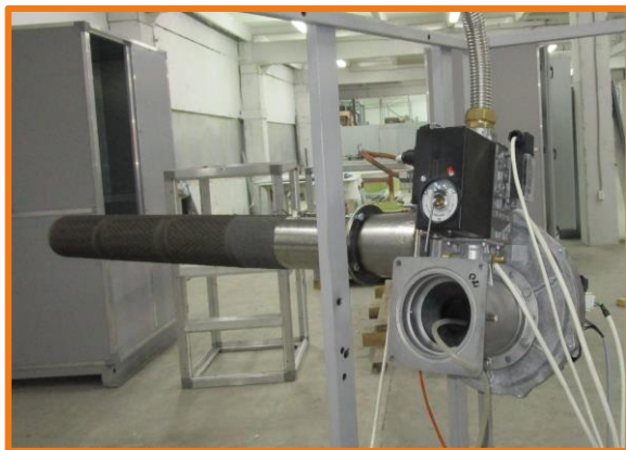
Сборка, установка и подключение горелки
