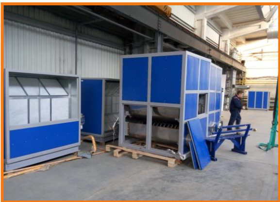
Установка съемных панелей 50 мм из минваты
